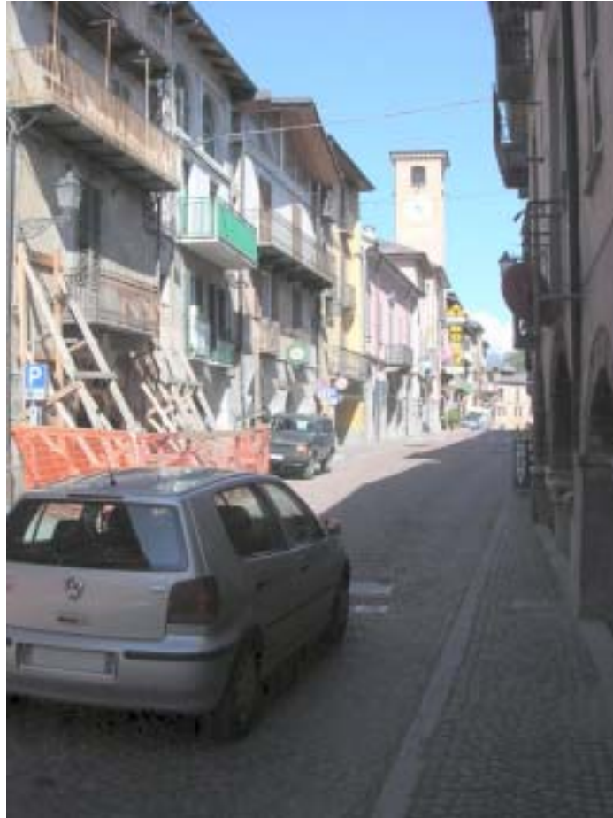
Foto 2 - Traffico veicolare transitante sulla strada confinante con le case ed irregolarità del manto stradale
