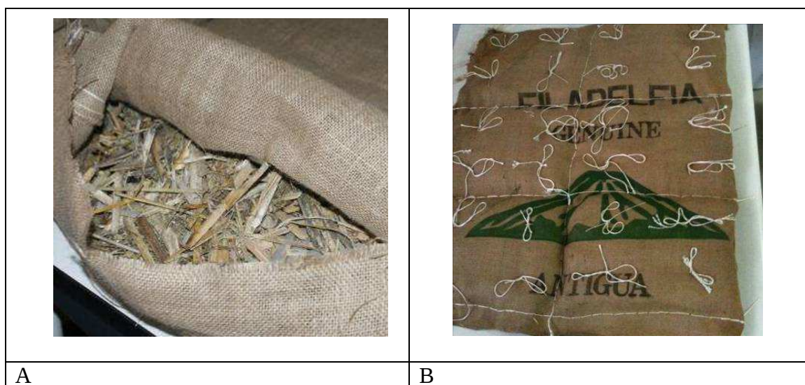
Figura 7 – (A) Inserimento delle canne triturate nei sacchi di juta. (B) Sacchi di juta chiusi e cuciti a maglie regolari (10 x 10 cm) per una distribuzione uniforme del materiale sciolto.
