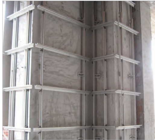
Figura 3.9 - Sottostruttura a montanti e traversi in lega di alluminio estrusa utilizzata per il montaggio del rivestimento mediante fissaggi di tipo nascosto agenti nei bordi lastra
