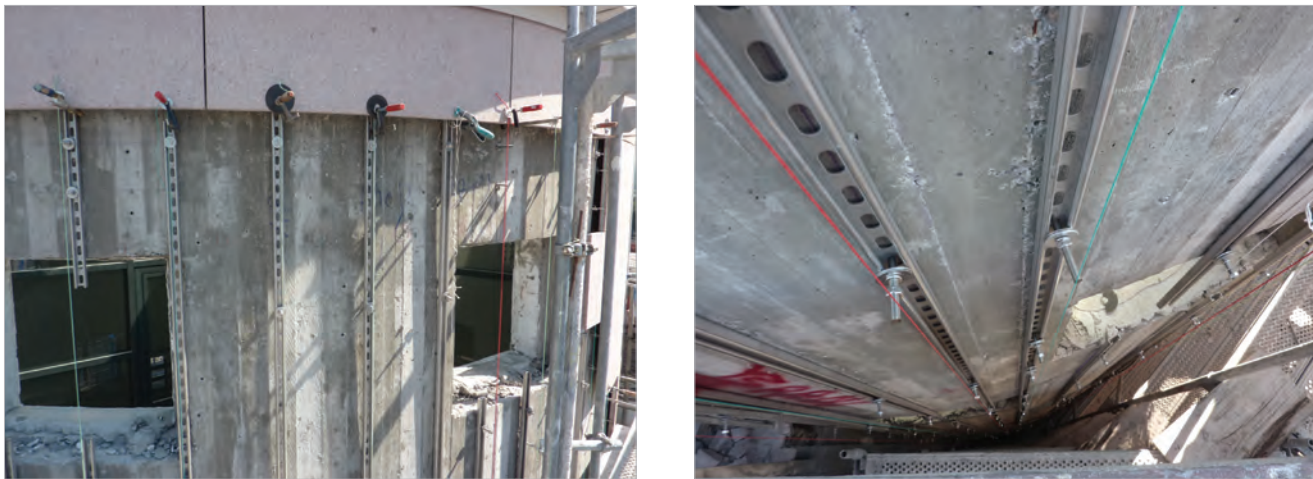
Figura 4.3 - Esempio di tracciamento della posizione nel piano della sottostruttura a montanti in acciaio mediante utilizzo di fili a piombo
