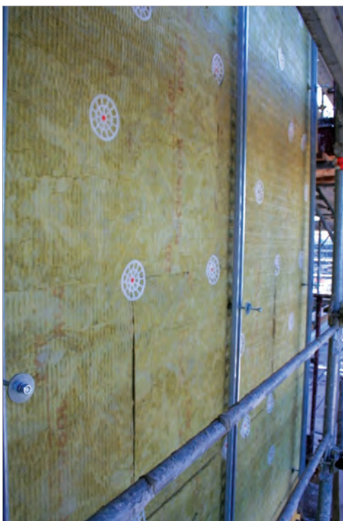
Figura 3.2 - Nell'immagine a sinistra, applicazione di pannelli isolanti in lana di roccia posati in doppio strato. In quella di destra si nota la posa di un telo impermeabile in materiale microporoso traspirante a protezione dell'isolante termico sottodavanzale. In primo piano si distinguono le staffe in alluminio pressofuso di sostegno della sottostruttura
