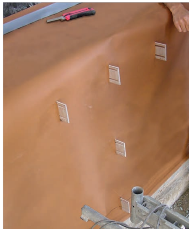
Figura 3.2 - Nell'immagine a sinistra, applicazione di pannelli isolanti in lana di roccia posati in doppio strato. In quella di destra si nota la posa di un telo impermeabile in materiale microporoso traspirante a protezione dell'isolante termico sottodavanzale. In primo piano si distinguono le staffe in alluminio pressofuso di sostegno della sottostruttura
