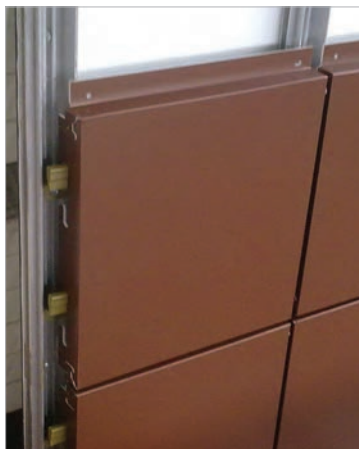
Figura 3.12 - Schematizzazione di un sistema a montanti con rivestimento metallico a cassetta il cui fianco è appositamente conformato per poter essere appeso al montante, realizzando così una modalità di fissaggio nascosta
