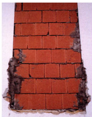
Fig. 2 - Chiusura di una finestra con blocchi in laterizio POROTON® di spessore 30 cm.
