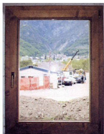
Fig. 3 - Serramento in legno posto in opera, visto dall'interno.
