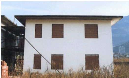
Fig. 1 - Edificio sperimentale: facciata ovest con le aperture tamponate.
