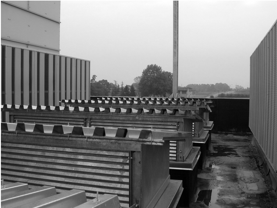
Fig. 5 – Griglie di aerazione ubicate in copertura.
