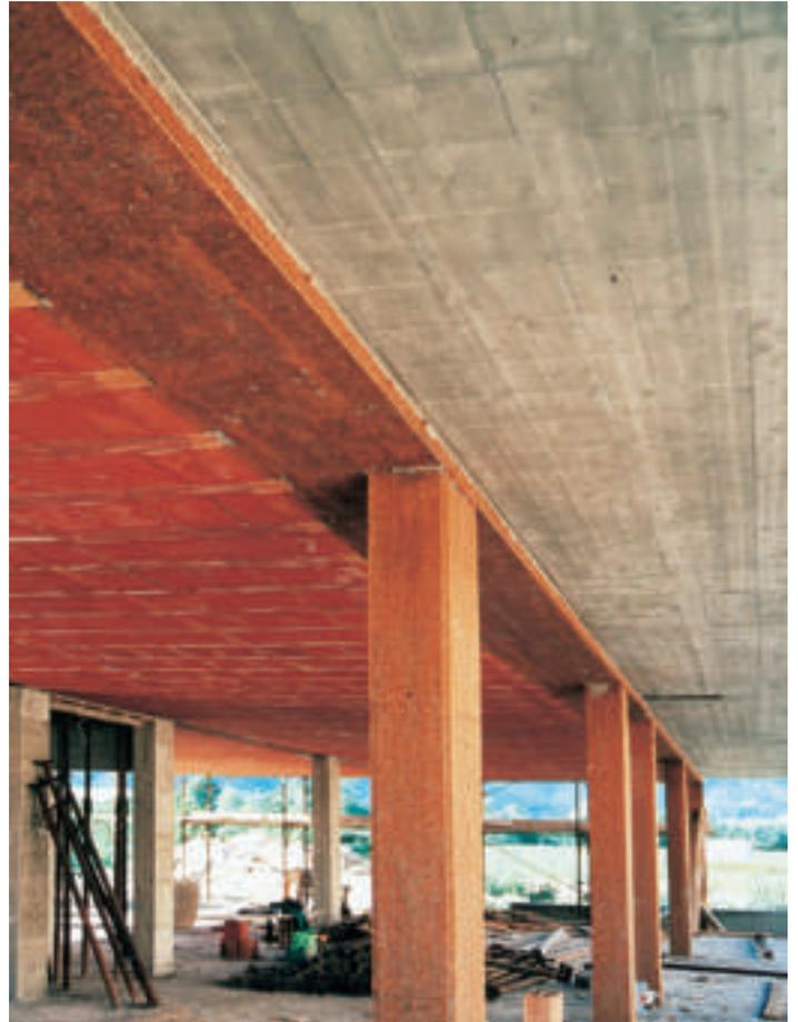
Protezione termoigrometrica di pilastri, travi orizzontali e corree eseguita con pannelli di sughero biondo naturale supercompatto in controscasso.
