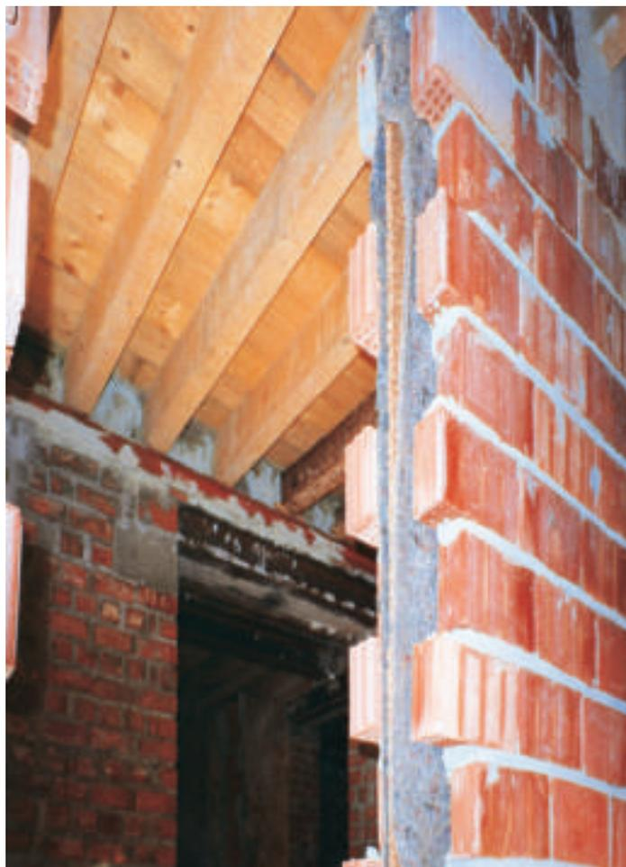
Particolari costruttivi del solaio e della partizione divisoria verticale realizzati nell'edificio di Corso Como a Milano.
