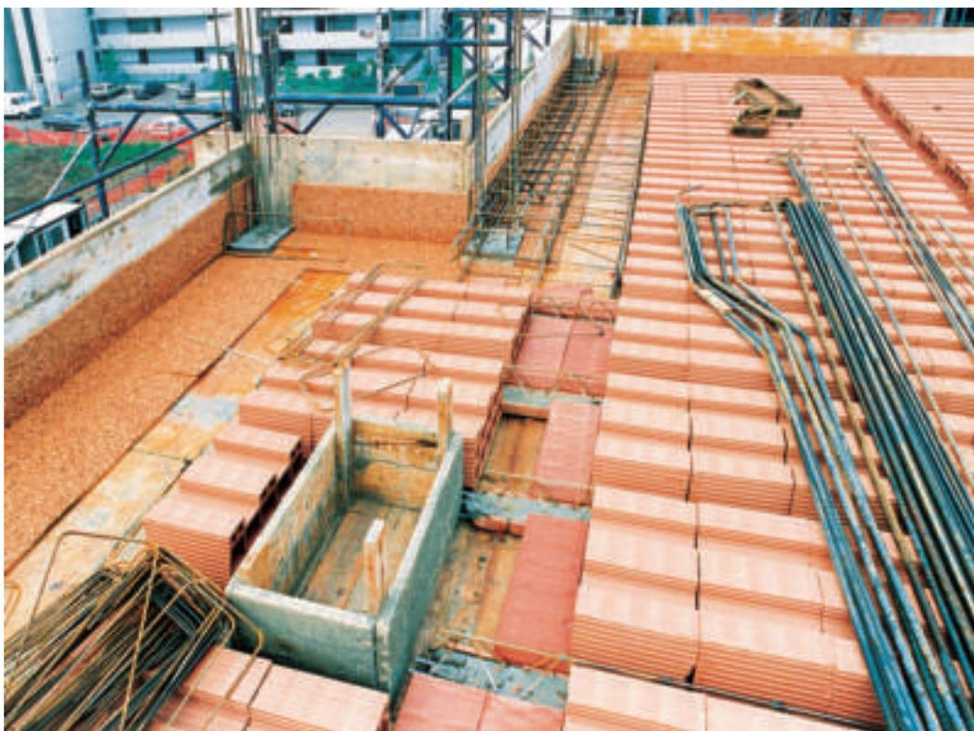
Protezione termoigrometrica delle corree e delle travi orizzontali con pannelli in sughero biondo naturale compresso SoKoVerd.AF
