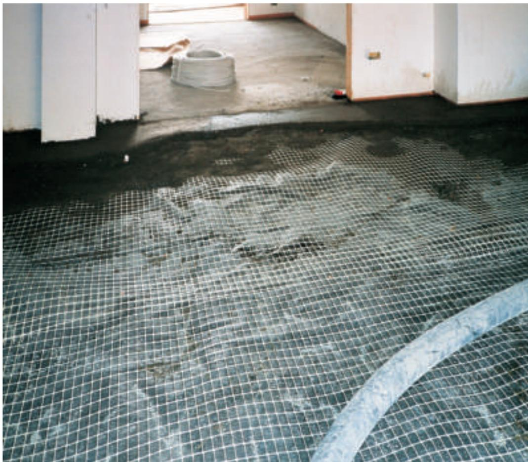
Formazione sul sottofondo di sughero del massetto in sabbia e cemento con rete antifessurazione biorientata in polipropilene
