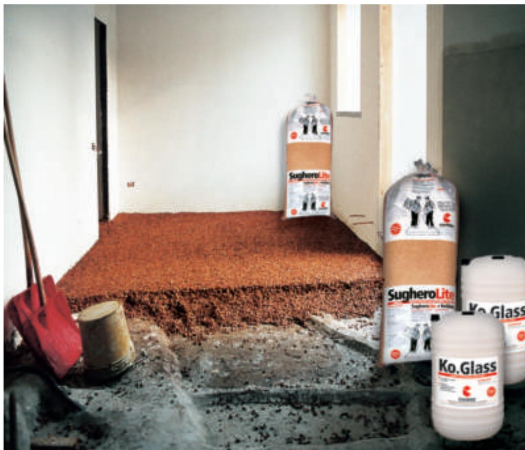
Sottofondo di sughero biondo naturale bollito e ventilato con vetrificante a presa aerea
