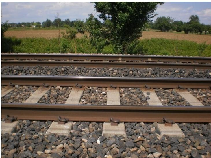
presumibilmente) con attacchi elastici di tipo indiretto Pandrol che fissano le rotaie alle sottostanti traverse in calcestruzzo, le quali affondano all'interno di un ballast costituito da pietrisco dalla diversa granulometria e dallo spessore di qualche centimetro qualsiasi sia la direzione di misura.
