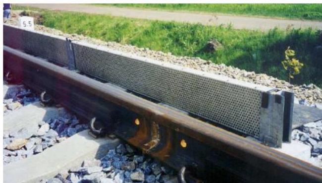
Figura 10. Esempio di barriere definite "basse".
