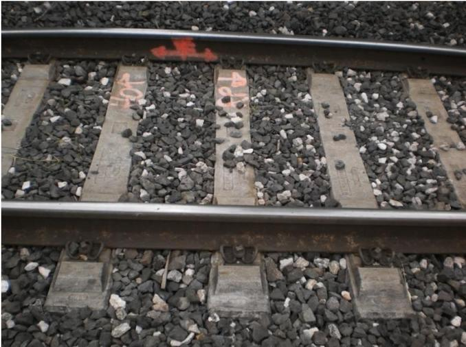
Riguardo il binario si tratta di un binario singolo del tipo classico con attacchi di tipo Vossloh che collegano le rotaie alle traverse in calcestruzzo. L'armamento affonda in una massicciata in pietrisco di varia pezzatura (spessore di qualche cm in ogni direzione di misura).
