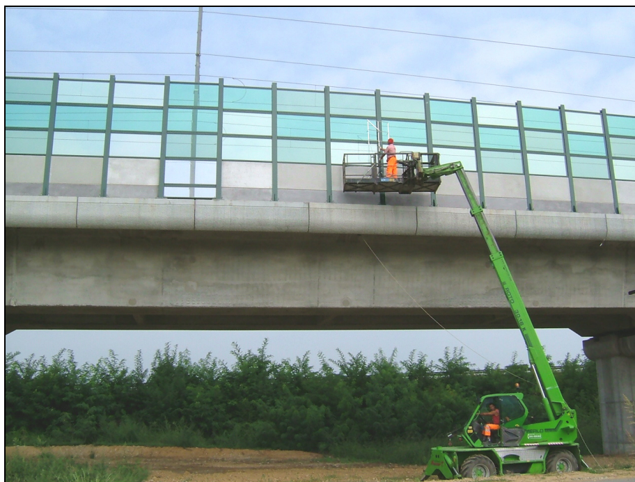
Figura 1 – Posizionamento della griglia microfonica lungo un viadotto
